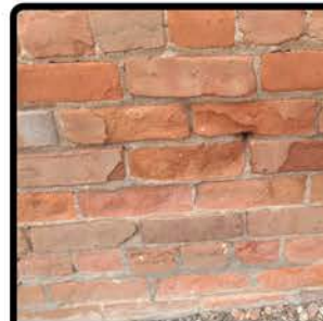
Spalling
